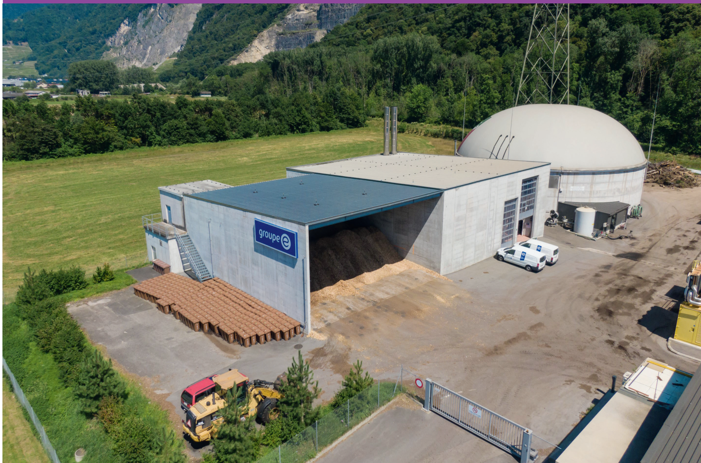
Un des chauffages à distance multi énergies de Groupe E.
