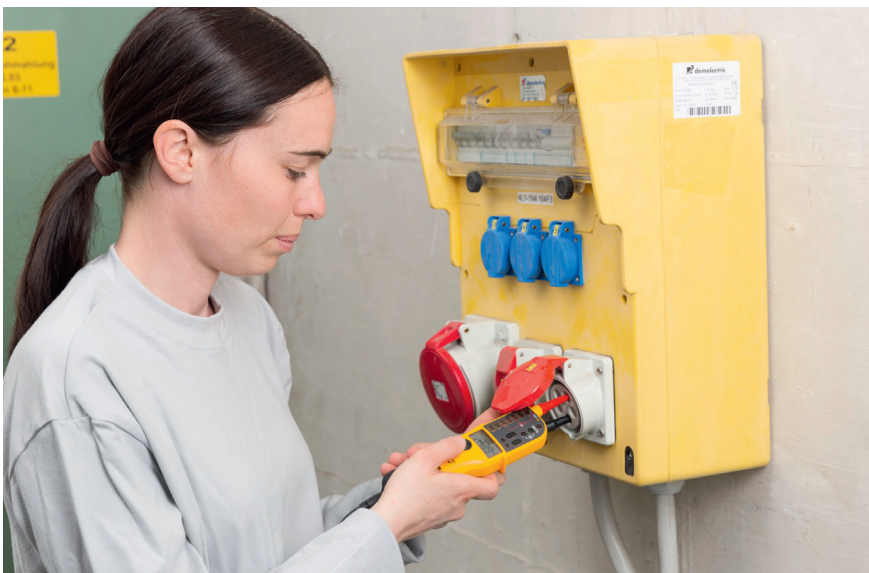
Bild 4 Messung bei einer Steckdose IP2X ohne PSA.
