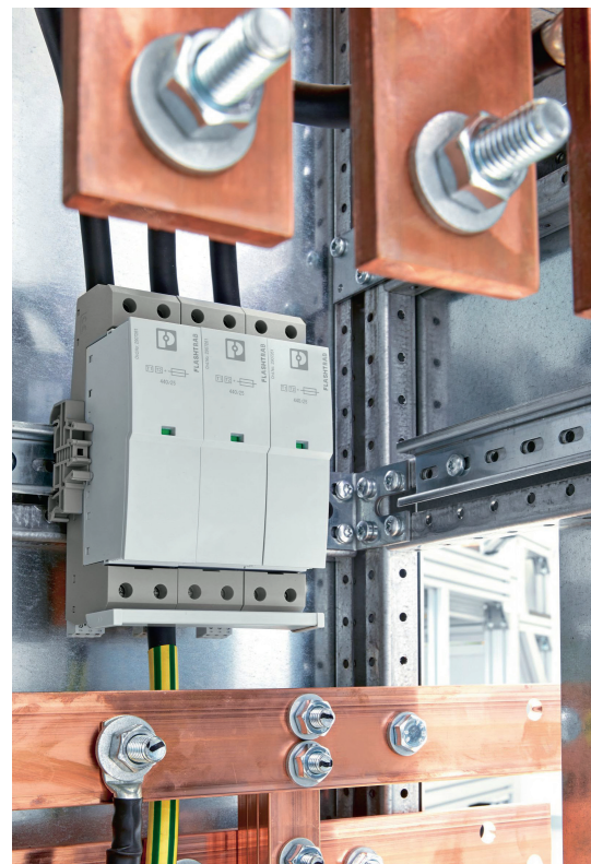
Überspannungsschutz-Stecker Typ 1 (Blitzstromableiter).
